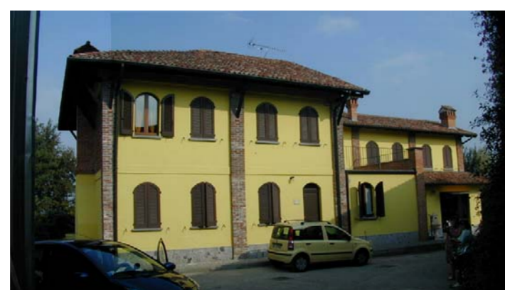
Uno dei fabbricati che costituivano l'insediamento, oggi recuperato (6).
