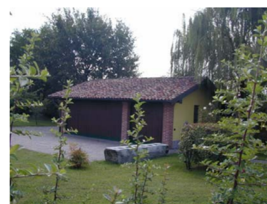
Un piccolo edificio accessorio (7).
